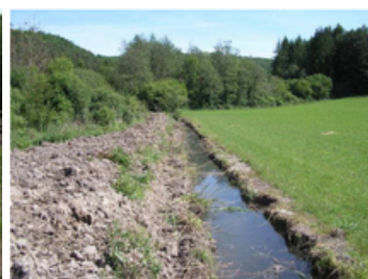
Creusement d'un fossé de drainage Villey-sur-Tille
